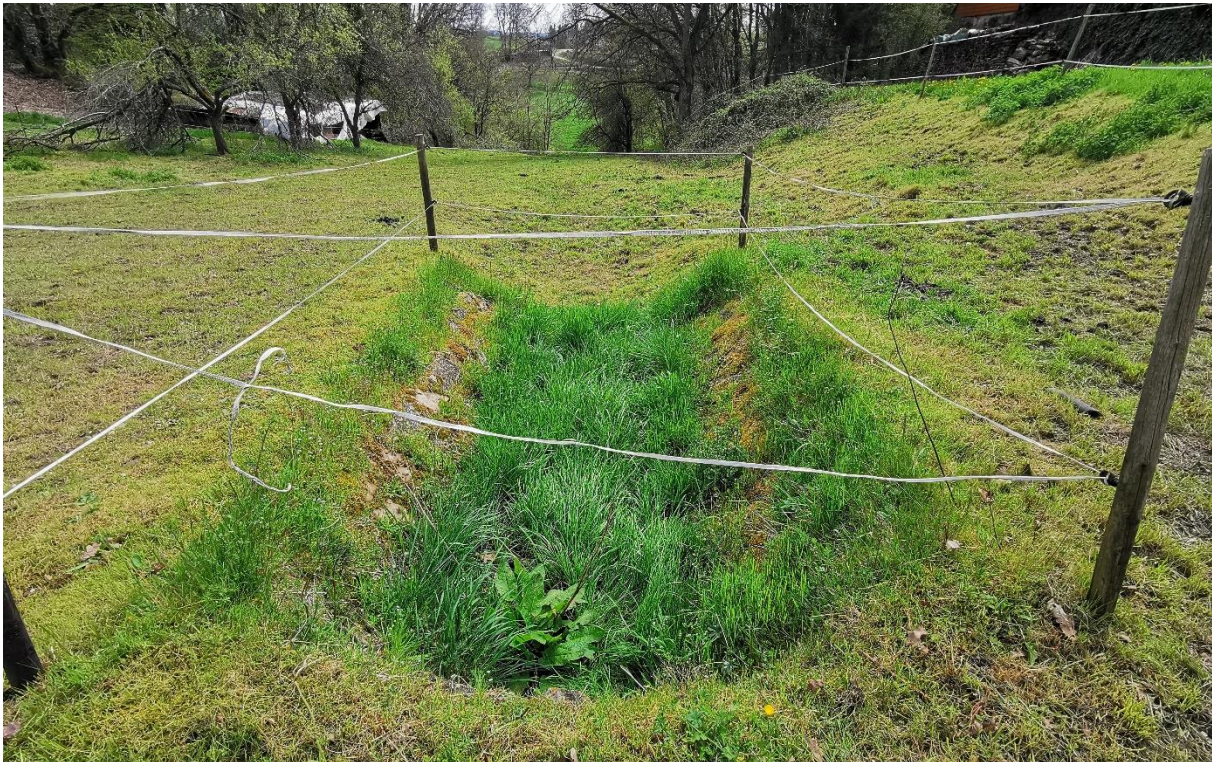
Abb. 11: Offener Auslauf der Oberflächenentwässerung im Zentrum der Fläche. Nässe- und Feuchtezeiger konnten nicht nachgewiesen werden.
